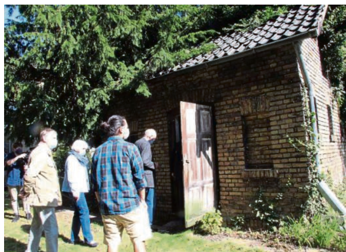
Im Gegensatz zur eigentlichen Synagoge ist das Gartenhäuschen vollständig erhalten geblieben.
