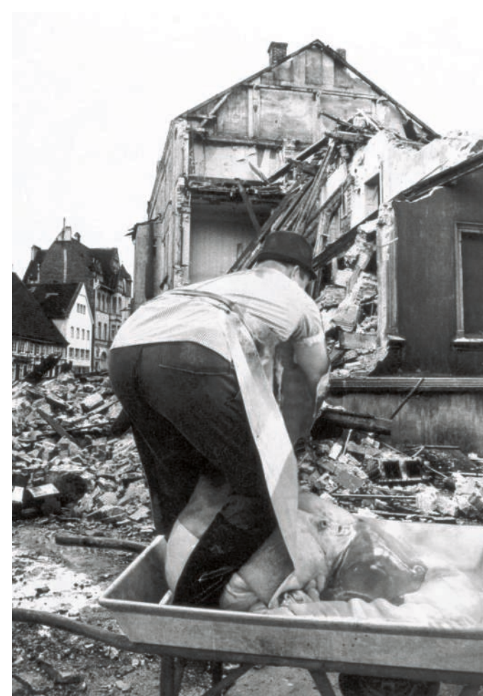
Die Fotografien und Fotocollagen von Horst Rottjakob-Stöwer zeugen von den massiven Eingriffen in die historische Bausubstanz in den Siebzigerjahren.
